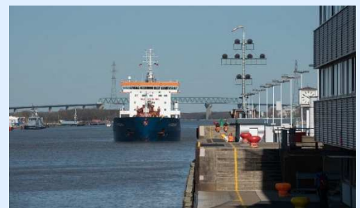
Schleuse in Brunsbüttel, Foto: Michael Ruff
