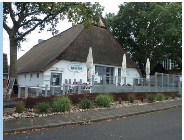
Abbildung 8: Foto des Gasthofs „Op de Deel“
