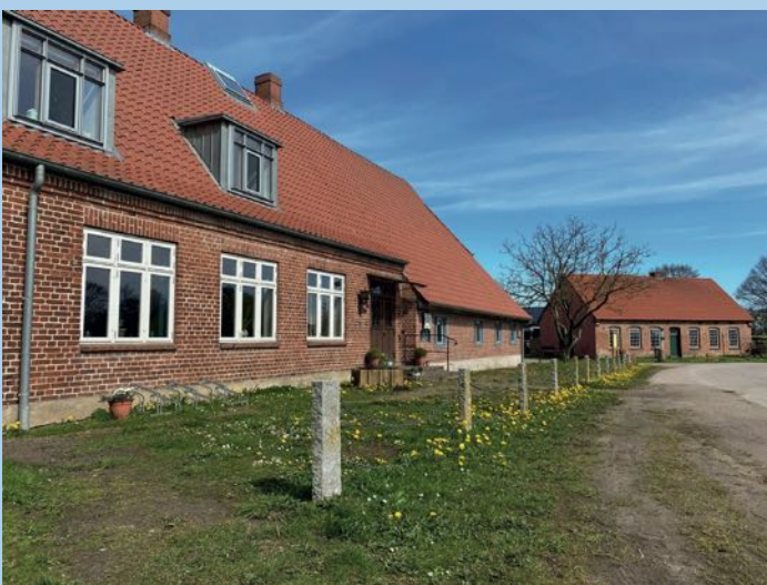
Abbildung 14: Der Hof Viehbrook von außen
